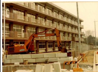
建設工事の様子
